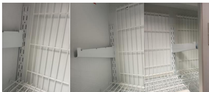
Fig. 10 - Mise en place du support
