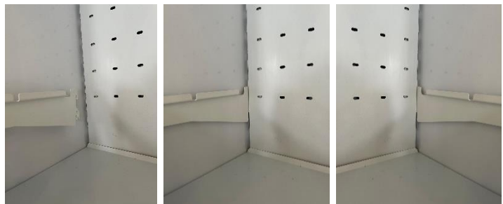
Abb. 13 - Einsetzen der Halterung
