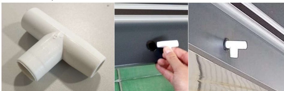
Abb. 9 - Darstellung des Einsetzens des T-Stücks
