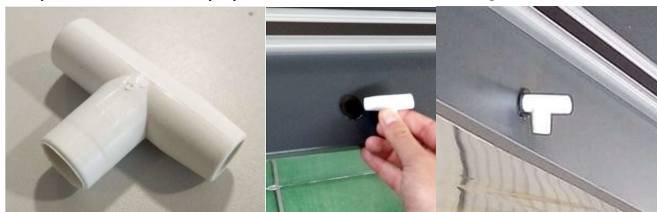
Fig. 9 - Ilustração de colocação do racor
